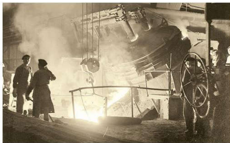
Выпуск металла из электросталеплавильной печи
