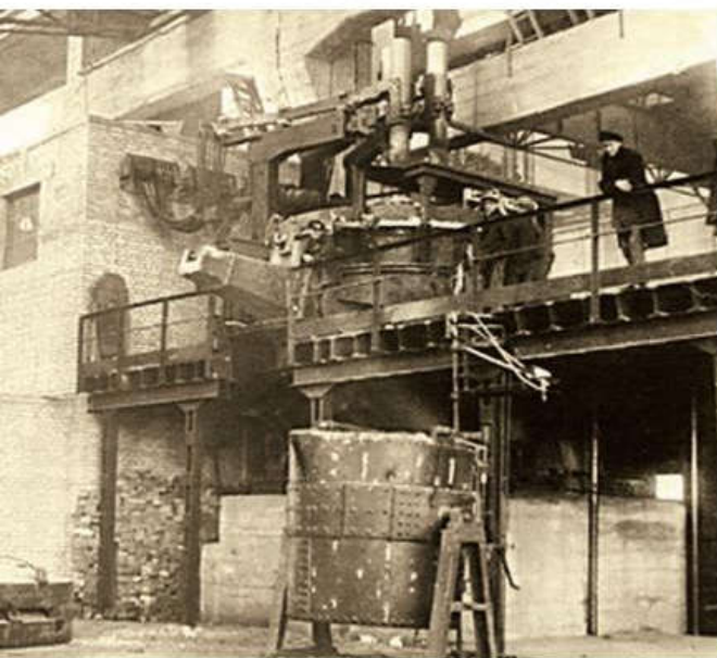
Рис. 7. Первая электросталеплавильная 10-тонная печь завода «Днепро-спецсталь» (производства фирмы «Демаг»), 1932 г.
