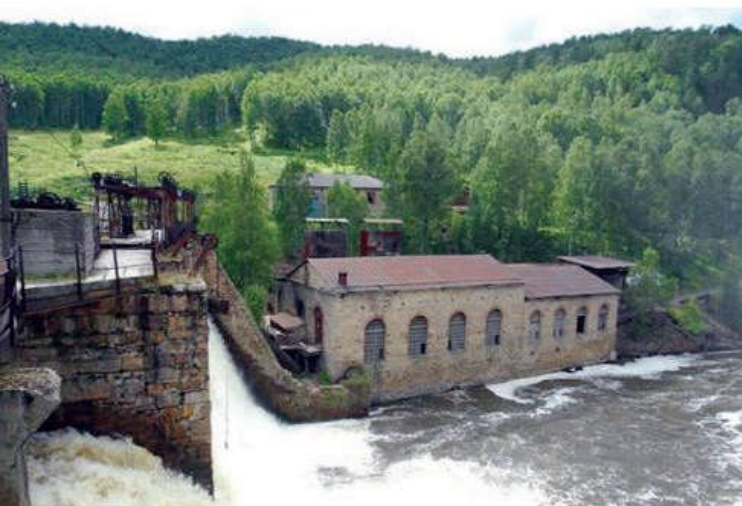
Рис. 4. Общий вид электрометаллургического завода «Пороги»
